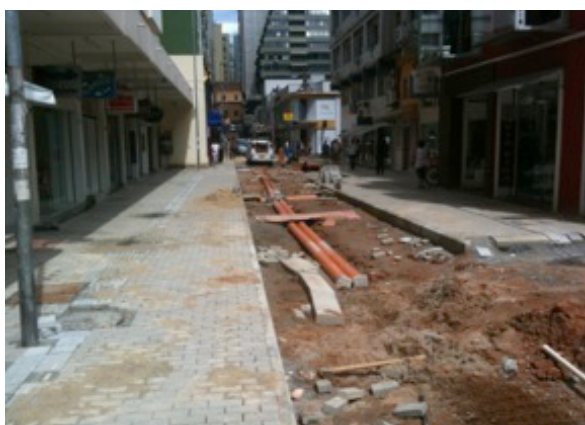
Obras de aterramento de cabos e instalação de nova tubulação de esgoto e drenagem (Foto: Divulgação).
